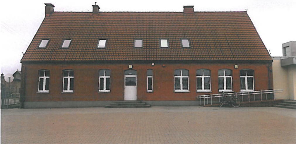
Fot. 30. Czyczkowy, ul. Główna 46. Budynek szkoły z początku XX w., zmodernizowany
