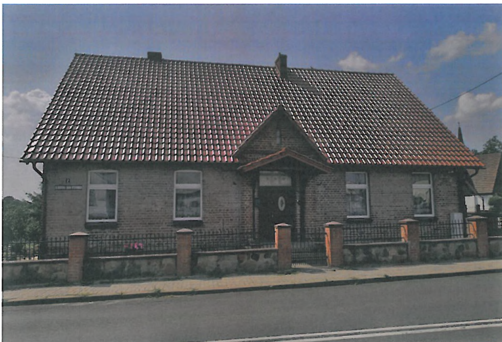
Fot. 8. Leśno, ul. Kardynała Wyszyńskiego 2. Budynek plebanii przy Kościele p.w. Podwyższenia Krzyża Świętego z ok. 1904 r.
