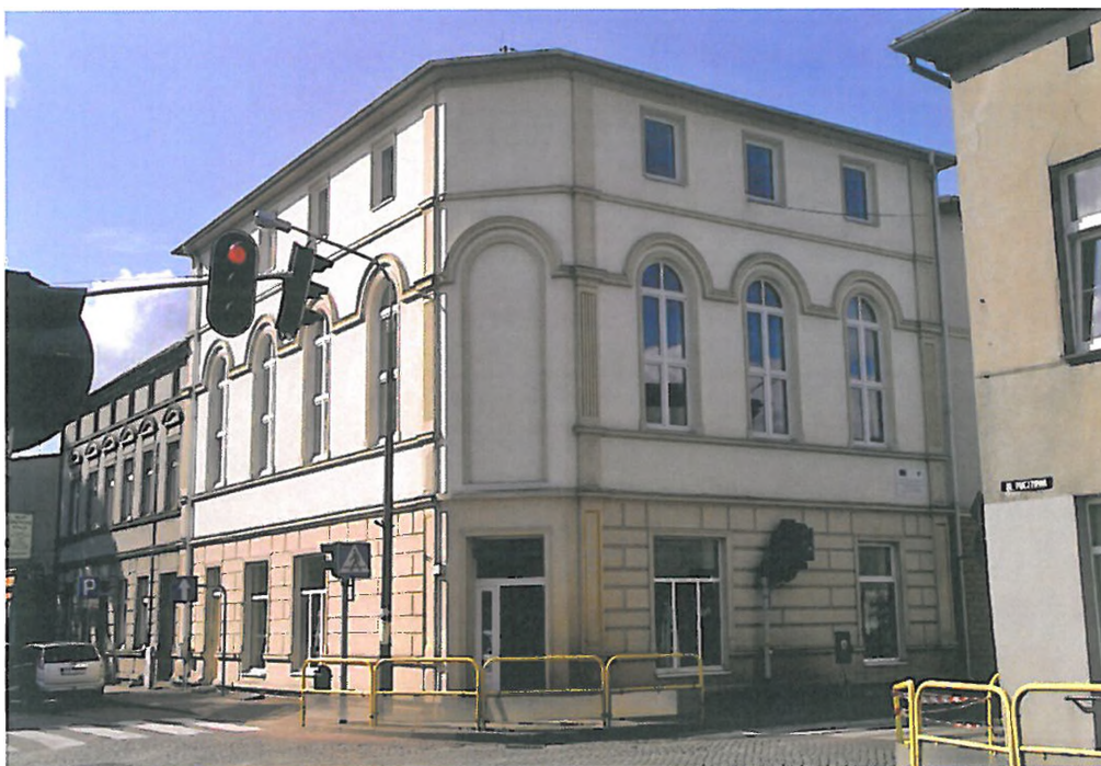
Fot. 16. Brusy, ul. Szkolna 2. Kamienica z ok. 1900 r.
