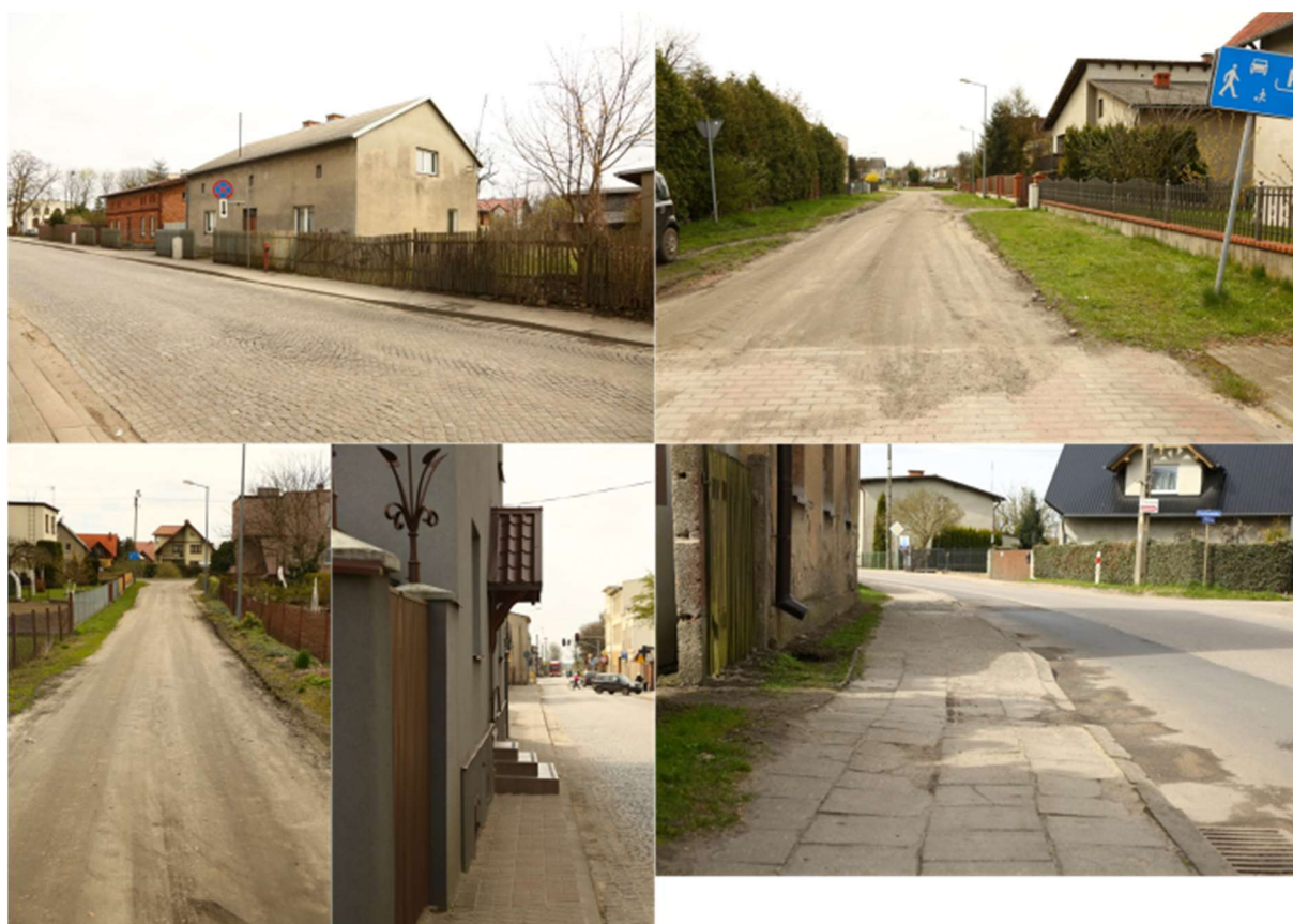
RYSUNEK 33. DOKUMENTACJA FOTOGRAFICZNA - STAN CIĄGÓW KOMUNIKACYJNYCH
