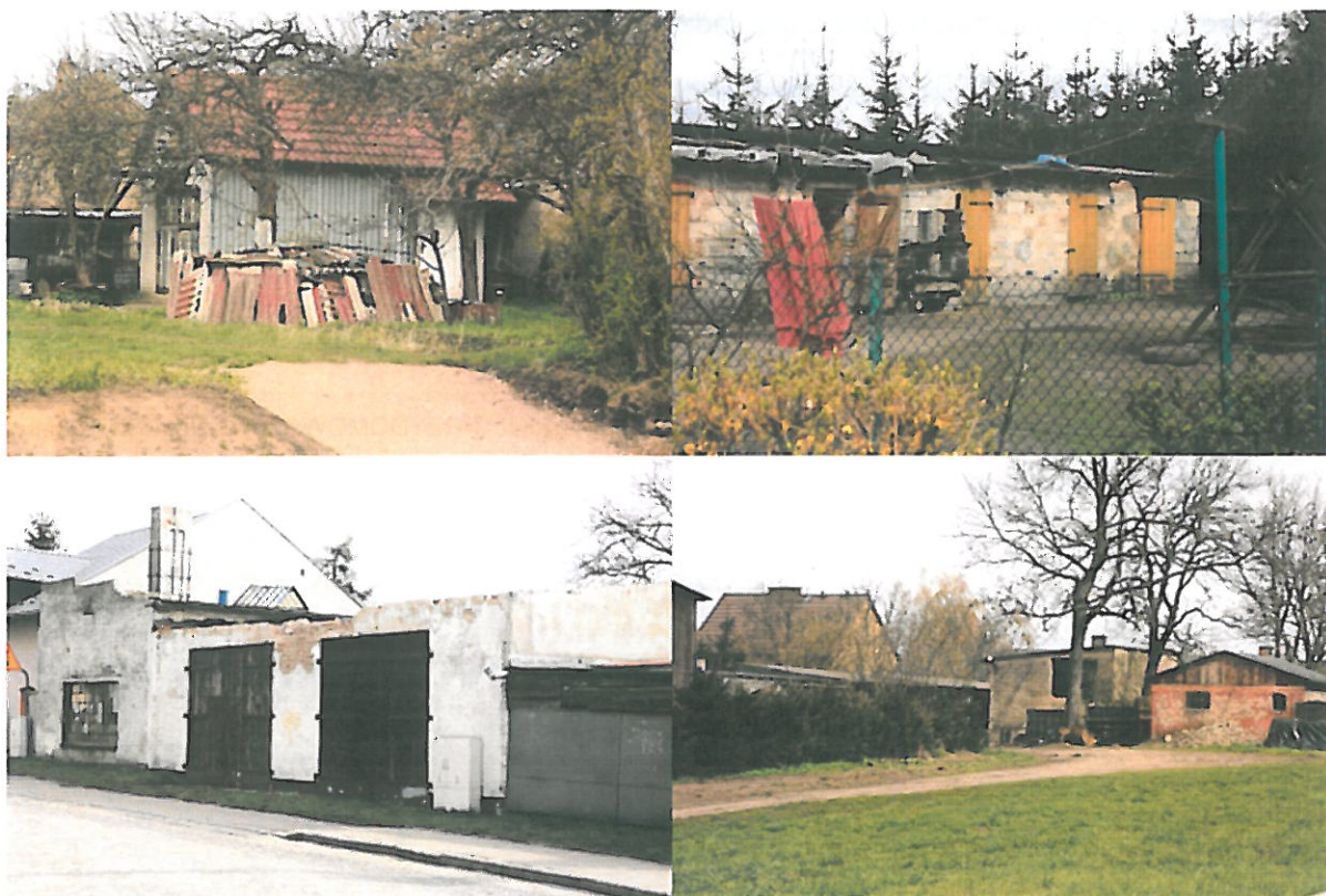
RYSUNEK 36. DOKUMENTACJA FOTOGRAFICZNA - STAN BUDYNKÓW GOSPODARCZYCH
