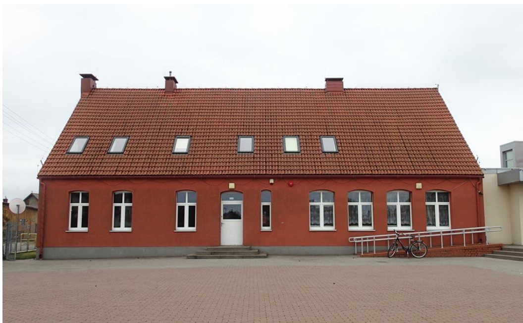
Fot. 30. Czyczkowy, ul. Główna 46. Budynek szkoły z początku XX w., zmodernizowany
