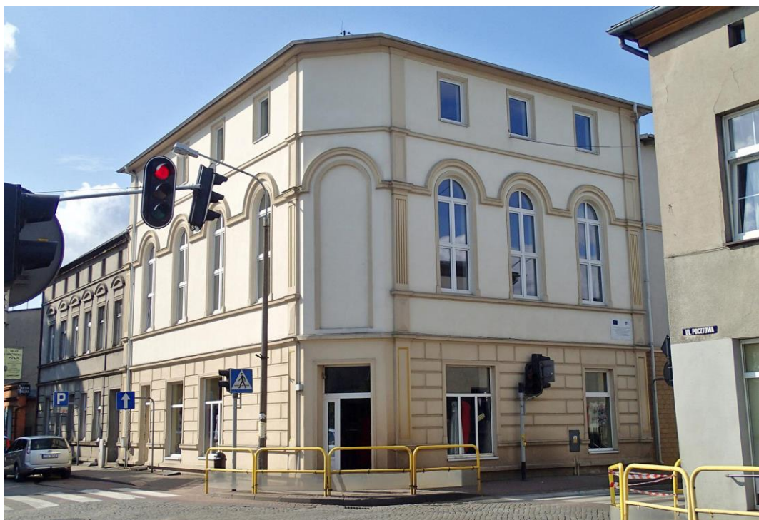
Fot. 16. Brusy, ul. Szkolna 2. Kamienica z ok. 1900 r.
