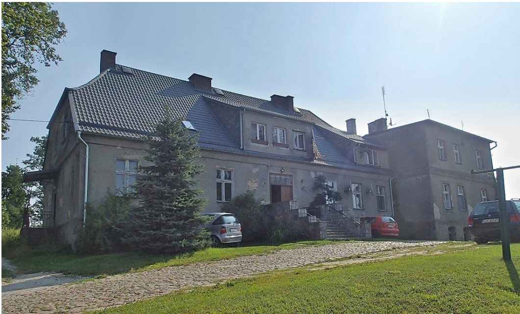
Fot. 12. Leśno, ul. Kaszubska 1-1A-1B. Dwór Sikorskich z 1. poł. XIX w.
