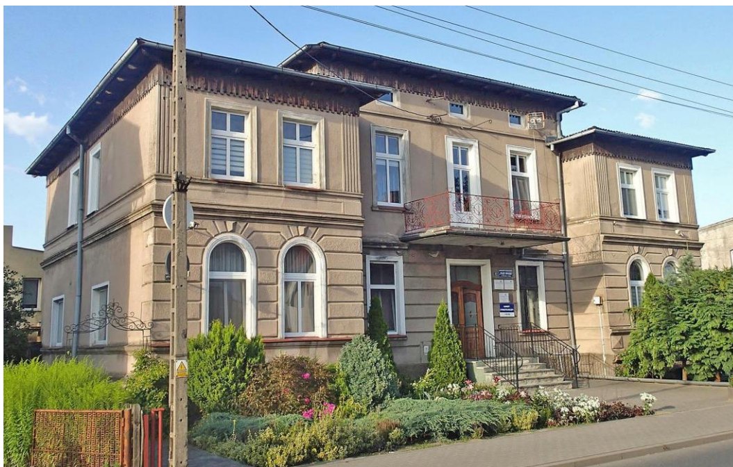
Fot. 17. Brusy, ul. Dworcowa 11-11A. Dawny dom Austenów z ok. 1900 r.
