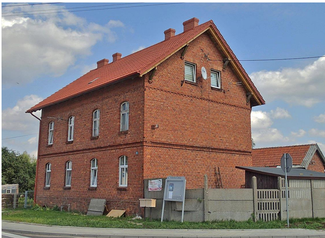
Fot. 28. Lubnia-Stacja, ul. Dworzec 6. Budynek mieszkalny przy stacji kolejowej z początku XX w.
